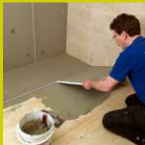
2. Presser le Multipanneau dans une liaison de briques posées sur chant dans la colle et laisser durcir la colle.
