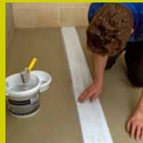
4. Achever les joints avec une bande de fibre de verre, armée d'une colle de carrelage.
