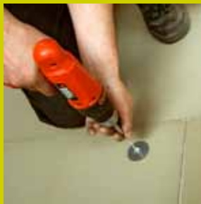
3. Poser le Multipanneau avec huit vis avec des rosettes de 30 mm sur le sol de bois.
