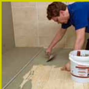
1. Poser une colle poudre élastique sur le sol plat.
