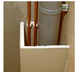
Sehr einfach Verkleiden von Rohrleitungen.
